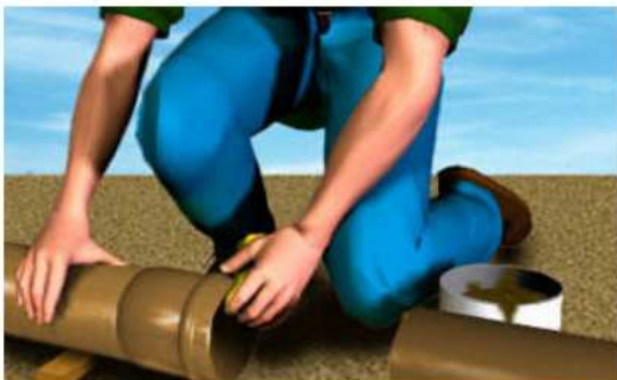
Figura 1 – Limpeza (Primeiramente serão limpas a bolsa e a ponta a serem conectadas)
