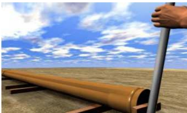
Figura 5 – Havendo dificuldade no encaixe recomenda-se a utilização de uma alavanca na sua conexão. Neste caso, a bolsa do tubo deverá ser protegida do contato com a alavanca com uma peça de madeira.
