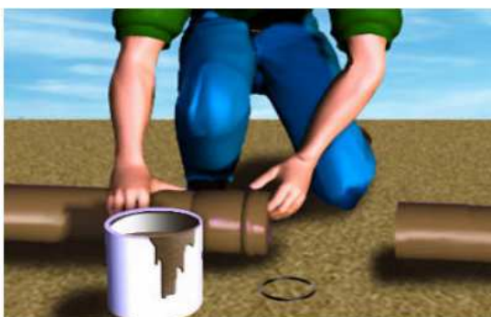
Figura 2 – Introdução do anel de Borracha (O anel de borracha será introduzido no sulco da bolsa)
